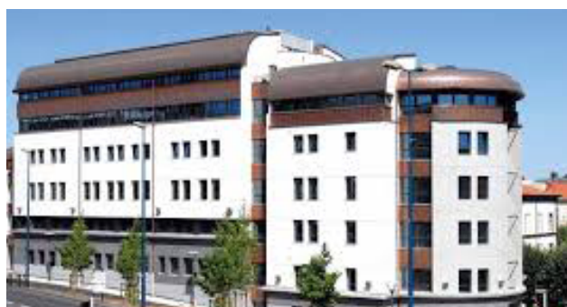
EDF bâtiment d'arrêt de tranche - Nogent-sur-marne
