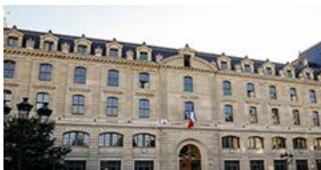
Préfecture de Police Rue Massillon à Paris
