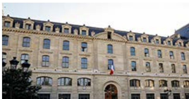
Préfecture de Police Rue Massillon à Paris
