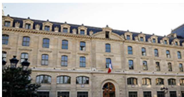
Préfecture de Police Rue Massillon à Paris
